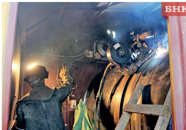
траншею на дне реки для прокладки трубы газопровода, варят трубы, которые вскоре пройдут гидравлические испытания.
