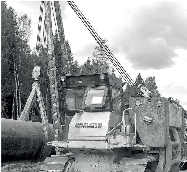
ляющей строительству) Богдан Киндрацкий. — После чего трубу аккуратно и поэтапно, чтобы не мешать навигации, «надвинут» в траншею. После укладки газопровода на проектное место будут произведены засыпка и финальные испытания. Завершить все работы планируется в третьем квартале 2019 года.
