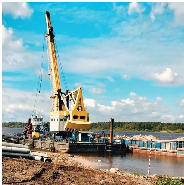
Плавкран готовит траншею для укладки нитки газопровода
