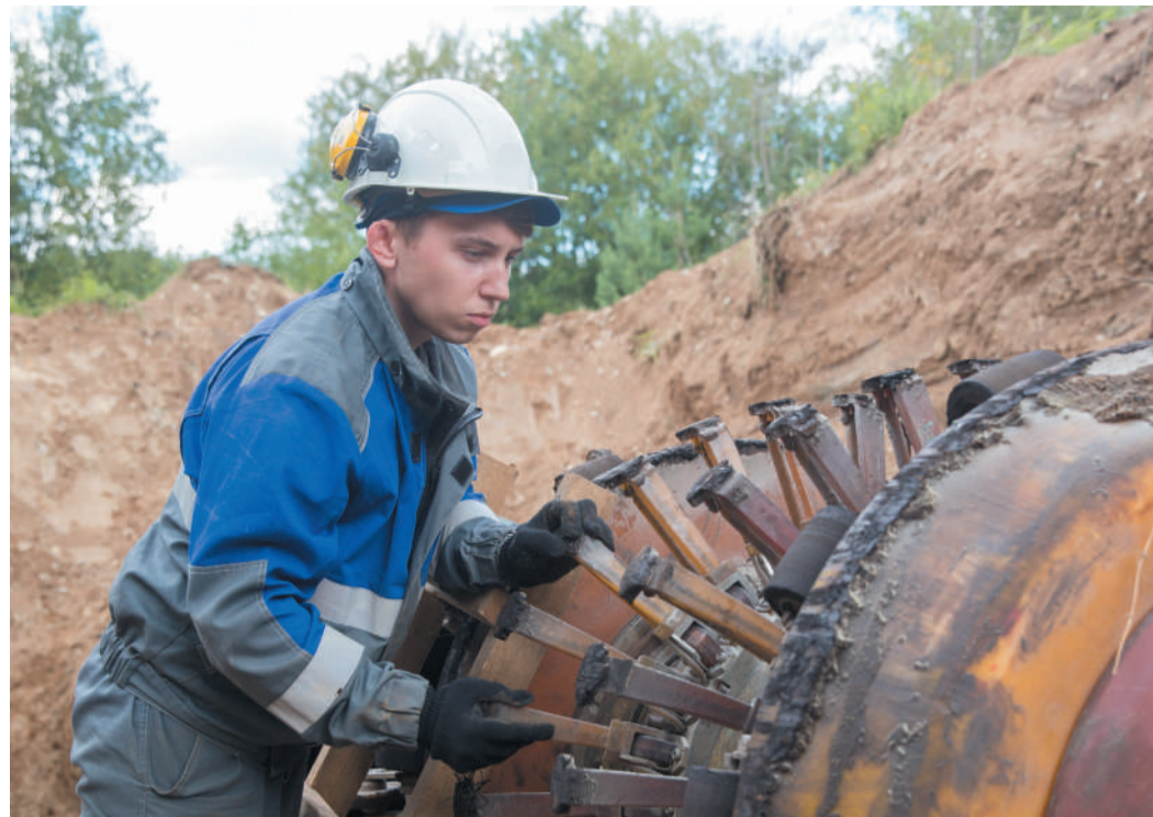
Работы проводит Даниил Богданов, обходчик линейный линейно-эксплуатационной службы Сосногорского ЛПУМГ
