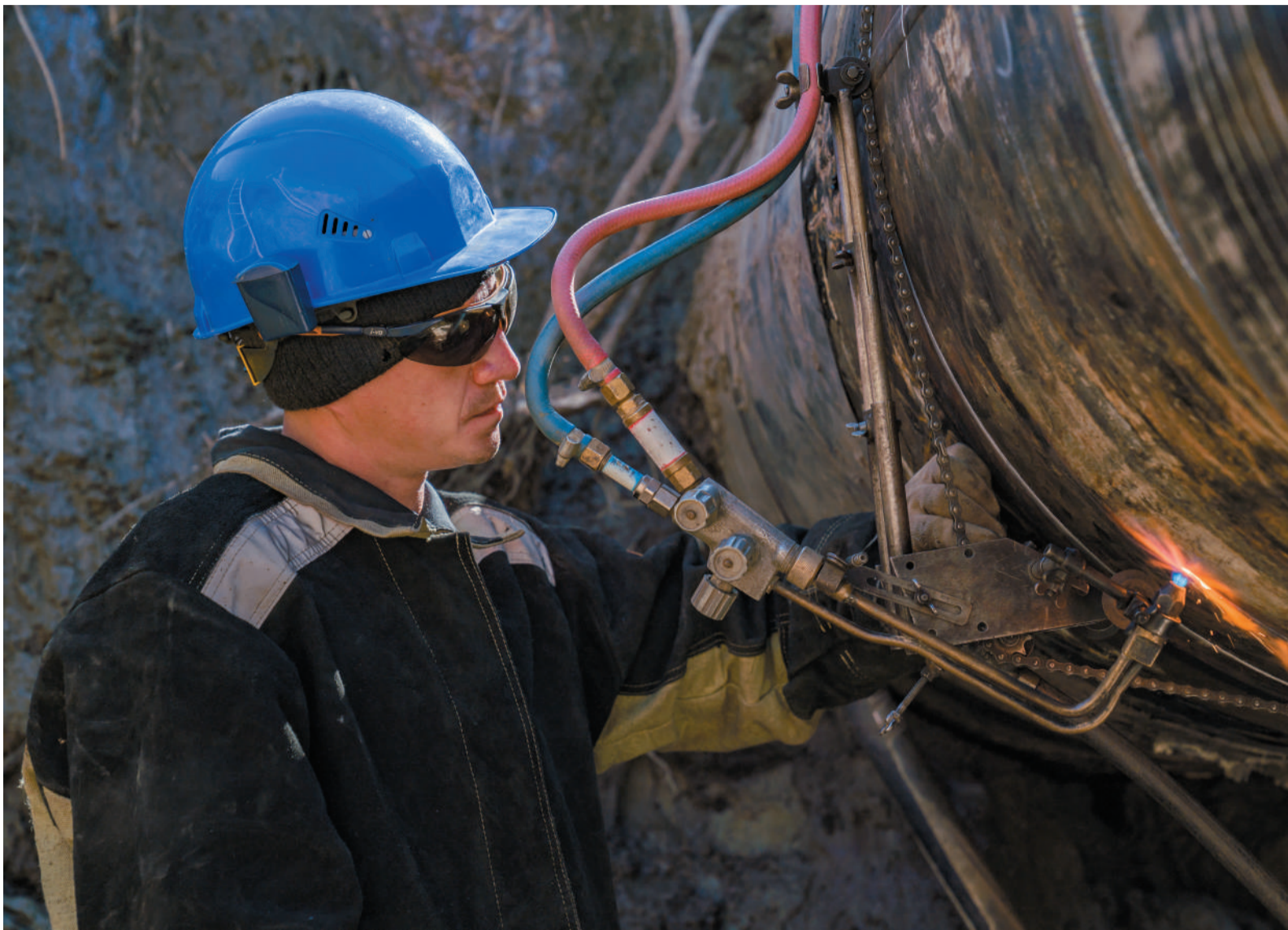
Электрогазосварщик 6 разряда УАВР Дмитрий Алексеевич Горячев выполняет чистовой рез на технологическом трубопроводе для последующего монтажа катушки
