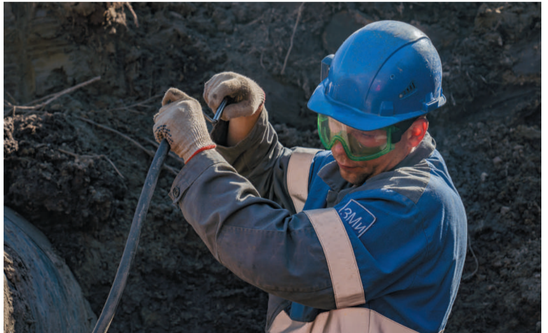
Владимир Алексеевич Власкин помогает бригадире Управления аварийно-восстановительных работ выполнить чистой рез на трубопроводе
