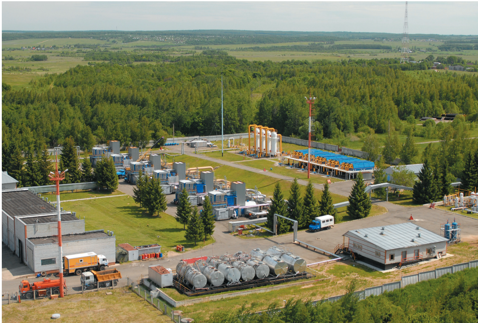
Компрессорная станция «Переславль» – основная промышленная площадка Переславского линейного производственного управления магистральных газопроводов в Переславле-Залесском
