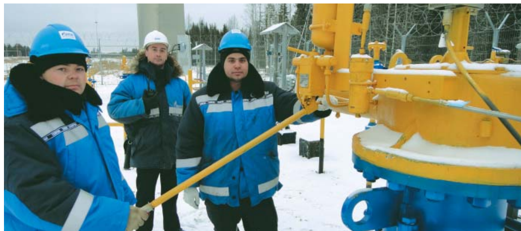
Линейный трубопроводчик А.В. Митяков, инженер ЛЭС Р.Б. Телятинский, линейный трубопроводчик Д.С. Есев
