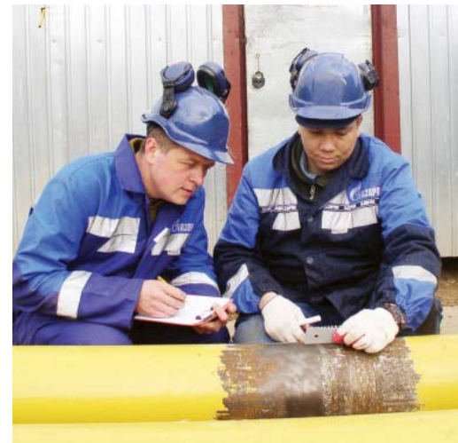
Начальник отдела ЛЧМГ А.А. Воробьев и инженер I категории отдела ТД А.В. Клевцов проводят обследование кольцевого сварного соединения технологического трубопровода ГРС
