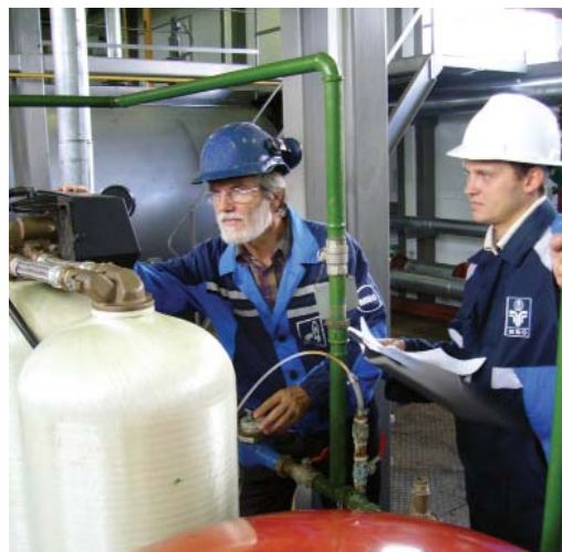
Начальник отдела ОТТО О.Р. Черемисин и инженер I категории ОАСУИТМ В.В. Лаврентьев производят режимно-наладочные испытания установки подготовки воды для системы теплоснабжения
