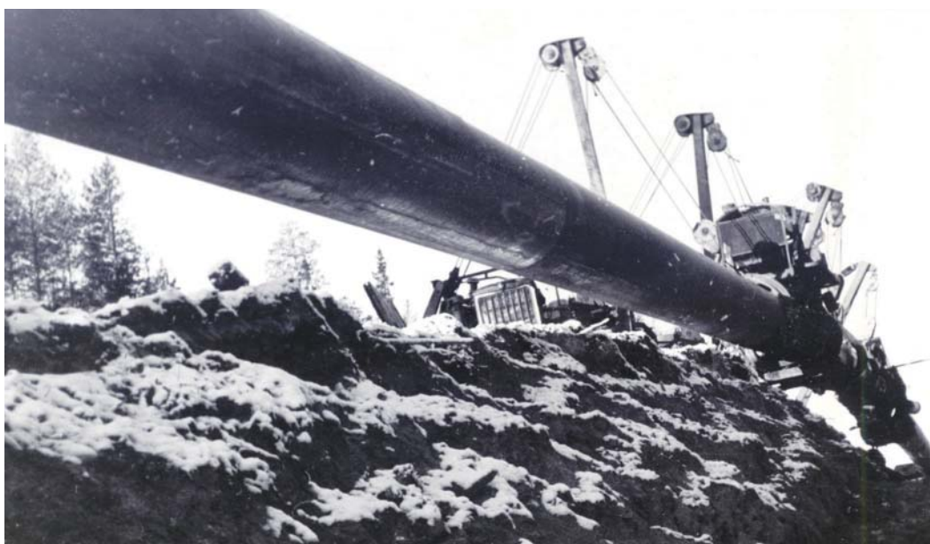
Изоляция труб газопровода «Сияние Севера» и укладка их в траншею на участке Сосновка. 1968 г.
