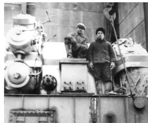
Монтаж первых турбин
