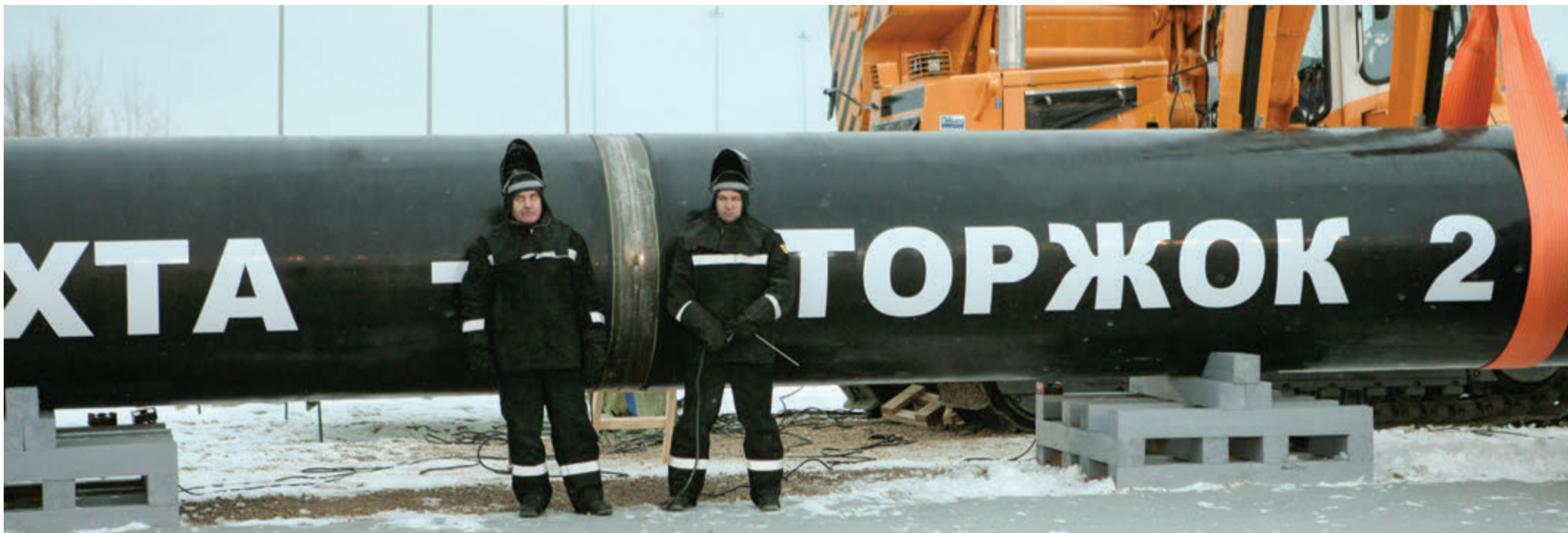
Историческую сварку провели лучшие сварщики ООО «Газпром трансгаз Ухта»: Владимир Ленц — электрогазосварщик-врезчик 6 разряда, УАВР. Его трудовой стаж 33 года. Дважды удостоен звания «Лучший сварщик Газпрома» — в 1995 и в 1997 году. Роман Кузнецов — электрогазосварщик 6 разряда, Сосногорское ЛПУМГ. Трудовой стаж 23 года. На конкурсе профессионального мастерства ПАО «Газпром» в 2009 году Роман стал призером.
