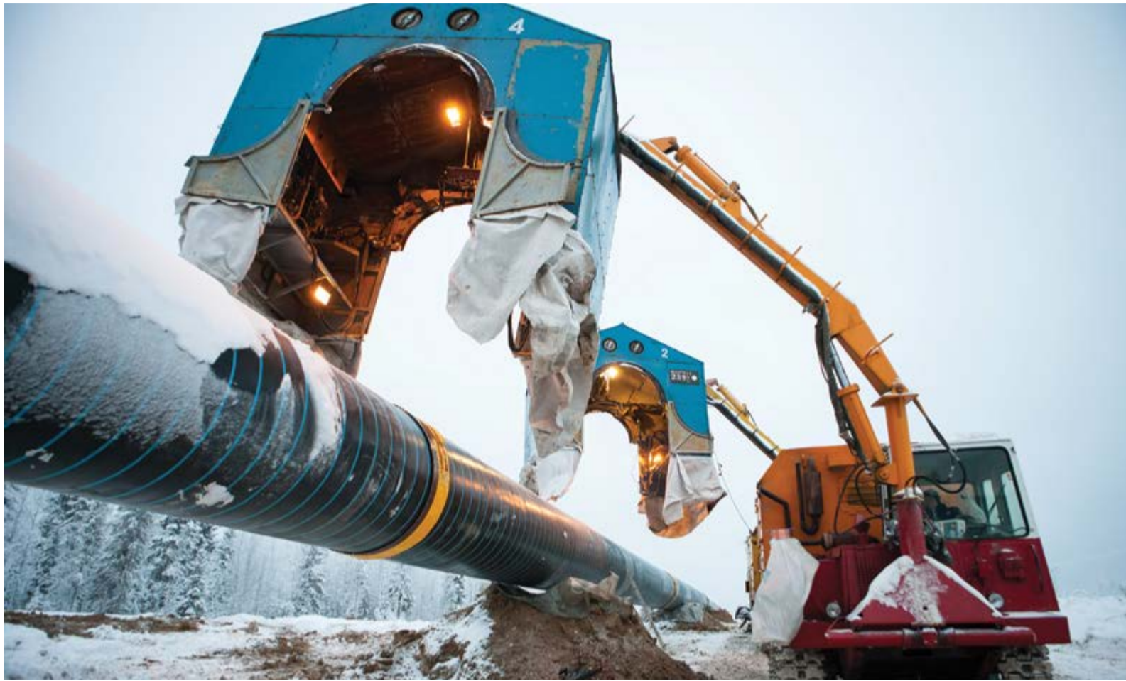
На одном из строительных объектов. Сосногорск
