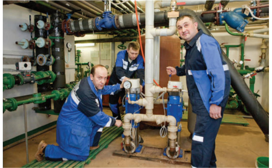
ТО насосного оборудования
