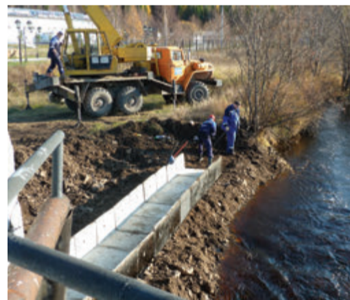
Укрепление берега ручья Нижний Доманик
