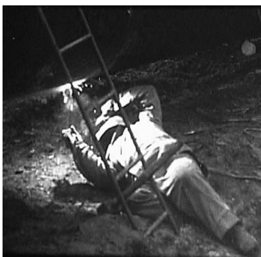
Кадры кинохроникисварки первого стыка магистрального газопровода «Ухта – Торжок I», 1967 год
