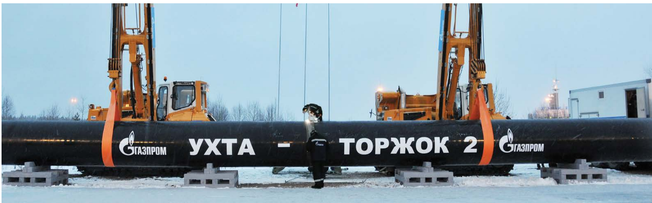
Сварка первого стыка МГ «Ухта – Торжок II» (Мегапроект «Ямал»). Сварщики Владимир Ленц и Роман Кузнецов, 2015 год
