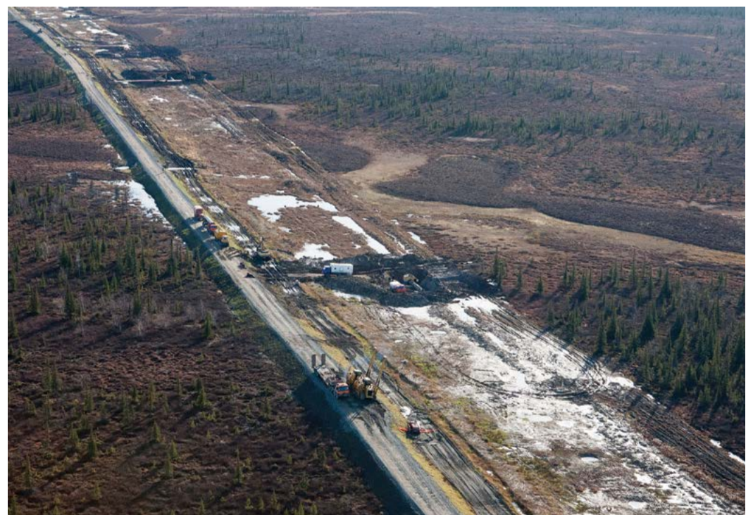
Трасса газопровода «Бованенково – Ухта-2»
