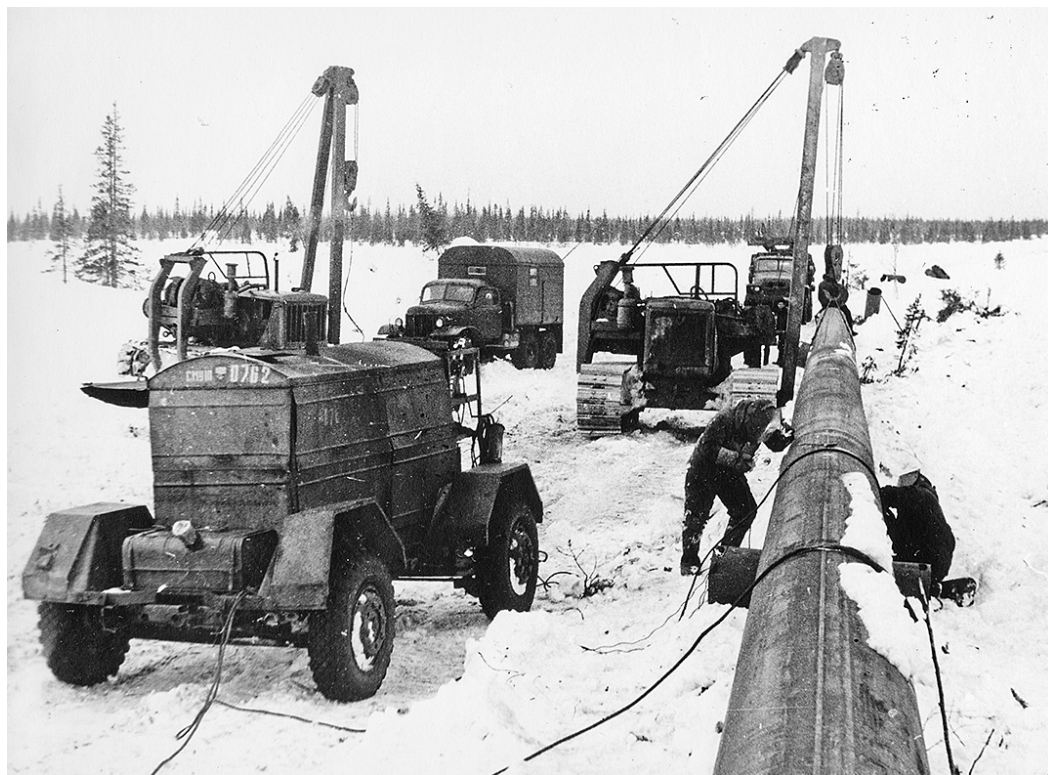
Строительство газопровода, 1967-1969 года
