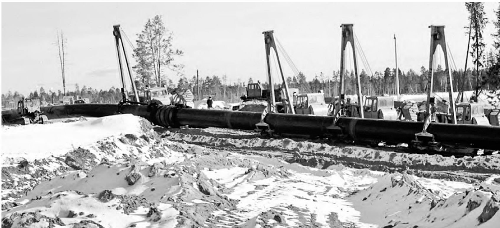
Изоляционные работы на газопроводе «Пунга – Вуктыл – Ухта II». Район Вуктыла, 1976 год
