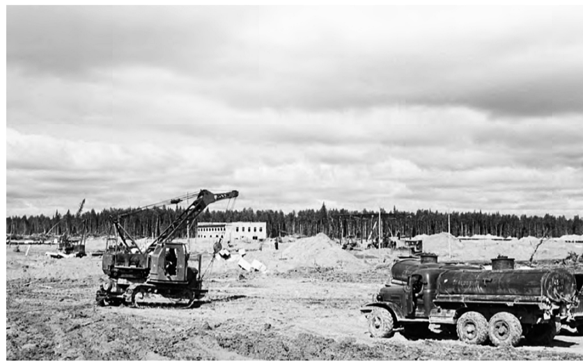
Панорама начала строительства. Вуктыл, 1967 год
