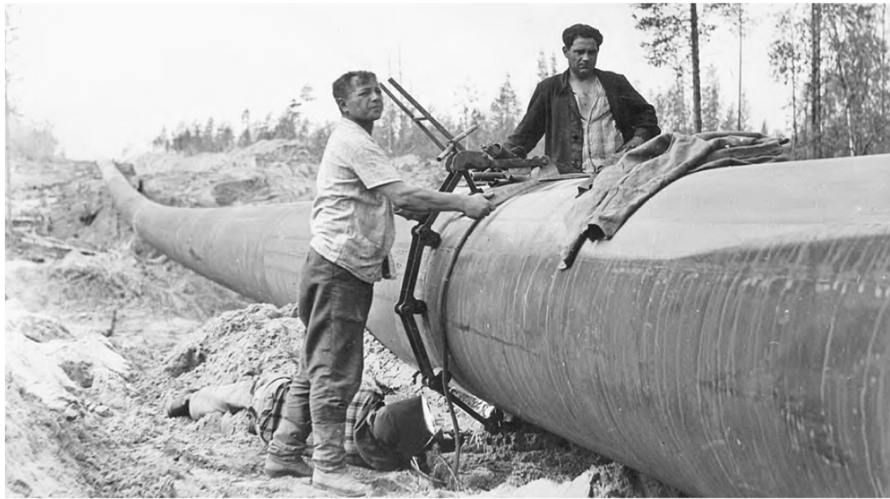
Строительство газопровода «Вуктыл – Ухта», 1970 год
