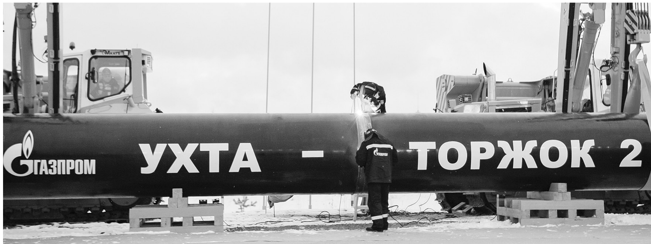
Сварка первого стыка «Ухта – Торжок II», 2015 год
