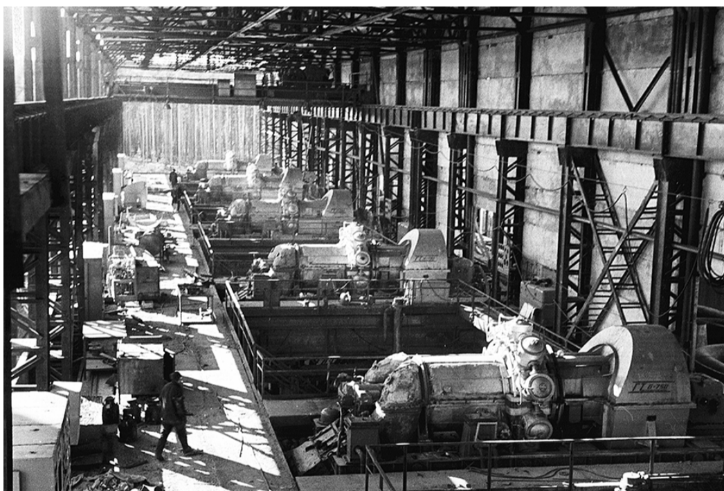
1970 год, КС-10, монтаж компрессоров ВЗ-9027
