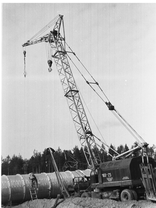
1970 год, КС-10, монтаж колонн системы воздухозабора
