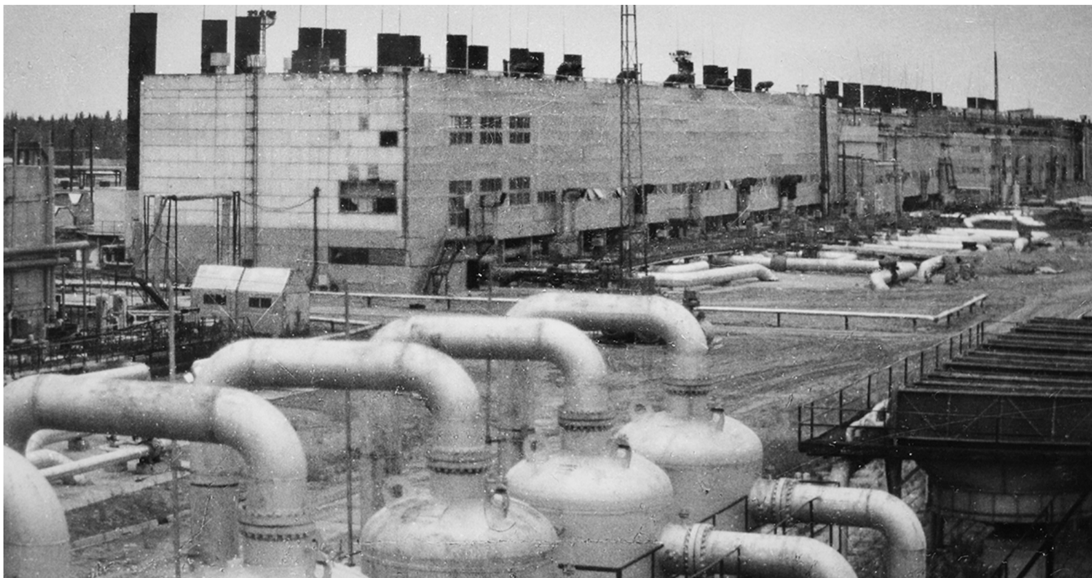
Общий вид КС-3 Вуктыльского ЛПУМГ
