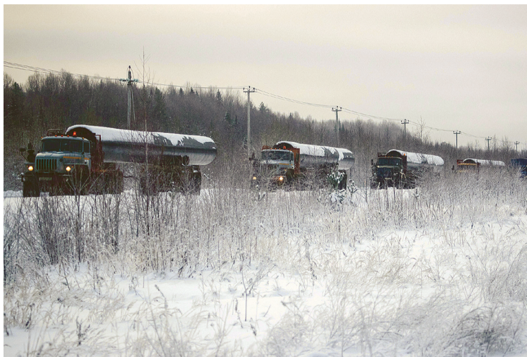
Колонны с трубами на подъезде к участку газопровода «Ухта – Торжок-2»
