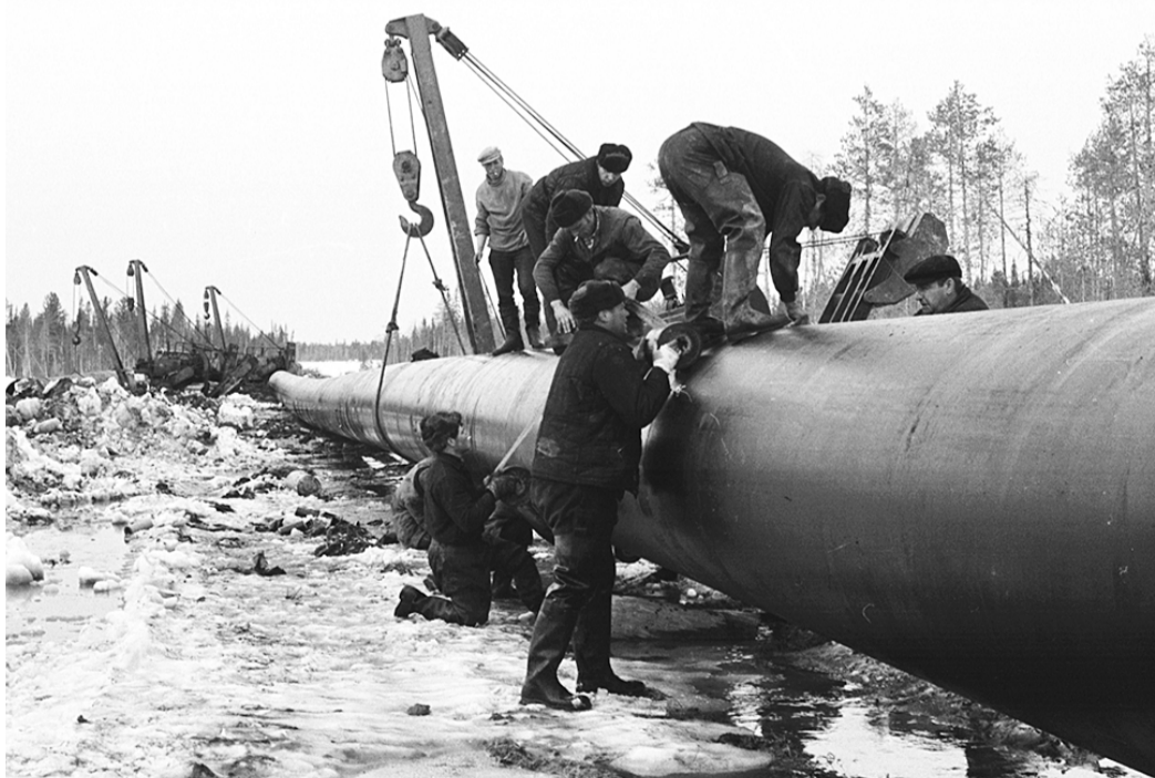
На фото – процесс изоляции сварочного шва вручную
