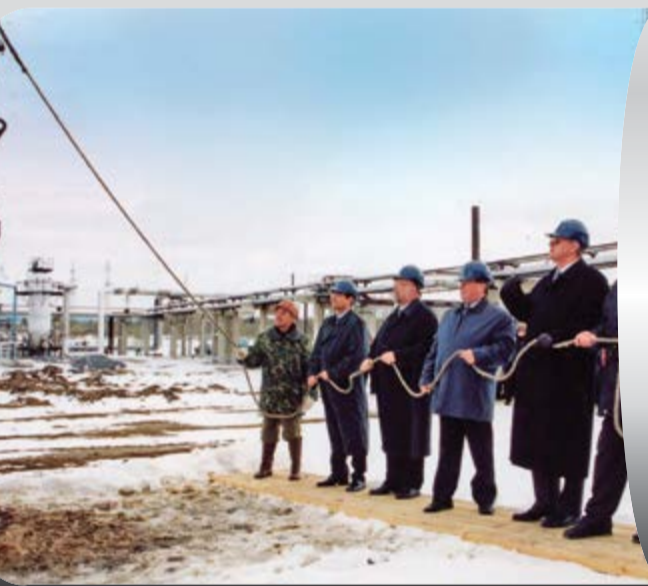
24 мая 2002 года. Забивка первой сваи в основание будущего комплекса по переработке газа. Ухта.
