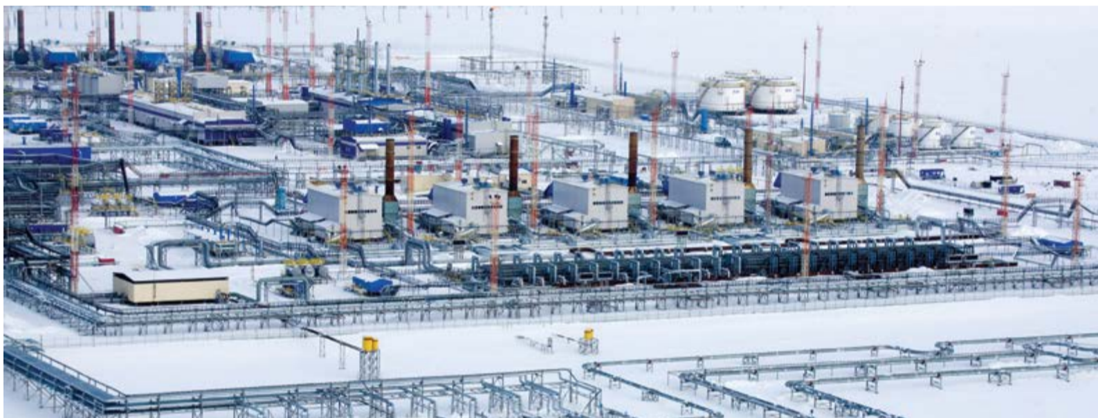
Дождливая компрессорная станция УКПГ- Бованенково. Фото предоставлено ООО «Газпром добыча Надым»
