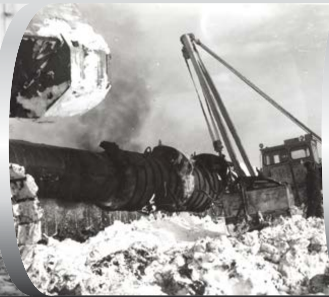
1981 год. Сварка «золотого стыка» магистрального газопровода «Пунга – Ухта» в 14 км от опорного пункта «Самоцветный» у подножия Уральских гор.
