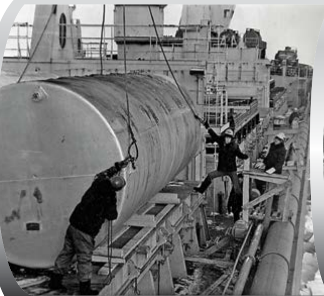
1 апреля 1987 года. Разгрузка резервуаров, строительной техники с борта ледокола «Архангельск» на мысе Харасавэй полуострова Ямал.
