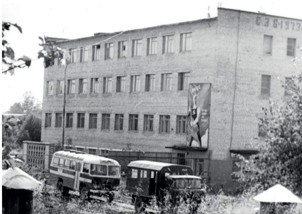
Строящееся здание Мышкинского ЛПУМГ силами УОВОФ, 1982 год
