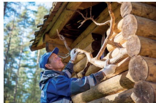
Монтаж декоративного элемента избушки Бабы Яги на территории пансионата «Лесная сказка»
