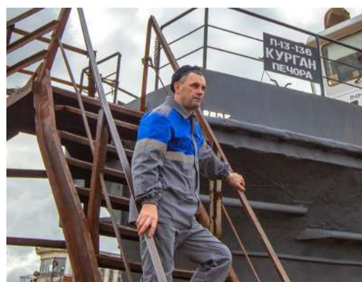
Для ремонта судна устанавливается специальный трап
