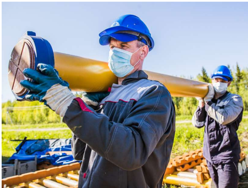
Работники подрядной организации готовят отрезки трубопроводной арматуры для монтажа
