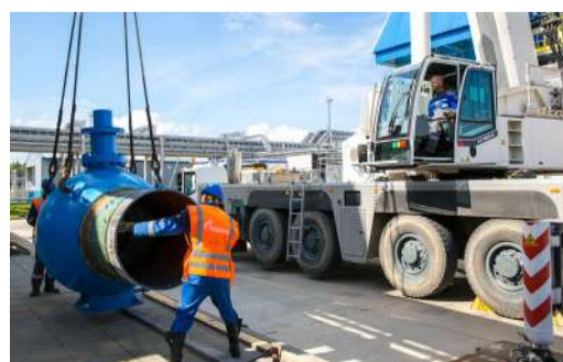
Перемещение шарового крана модульной обвязки газоперекачивающего агрегата весом 10 тонн
