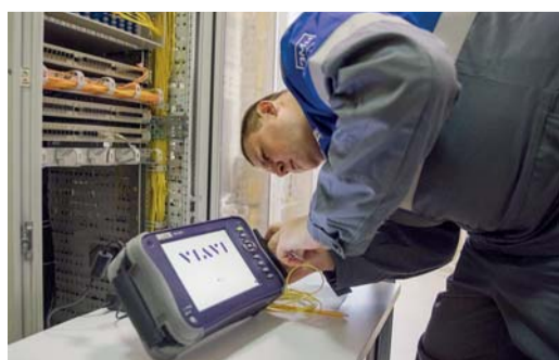
Подготовка к измерению волоконно-оптического кабеля
