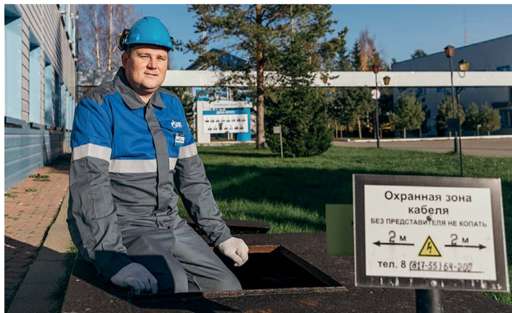
Владимир Серов во время осмотра кабельного колодца
