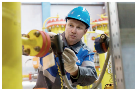
Техническое обслуживание и настройка датчиков уровня фильтров
