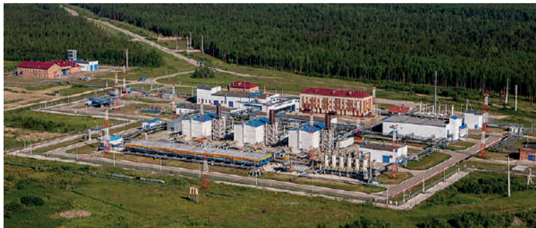
КС «Ухтинская» с газоперекачивающими агрегатами «Балтика-25»
