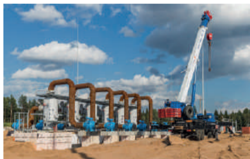
Строительство нового цеха в Приводинском ЛПУМГ
