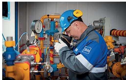
Проверка отсутствия загазованности газоанализатором
