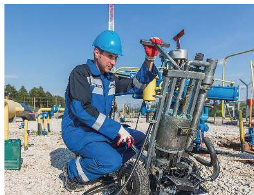
Набивка уплотнений крана
