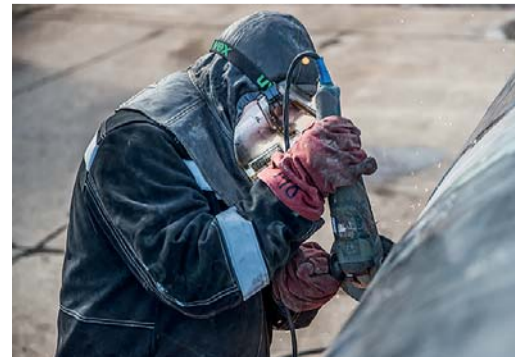
Послойная зачистка сварного соединения шлифовальной машинкой
