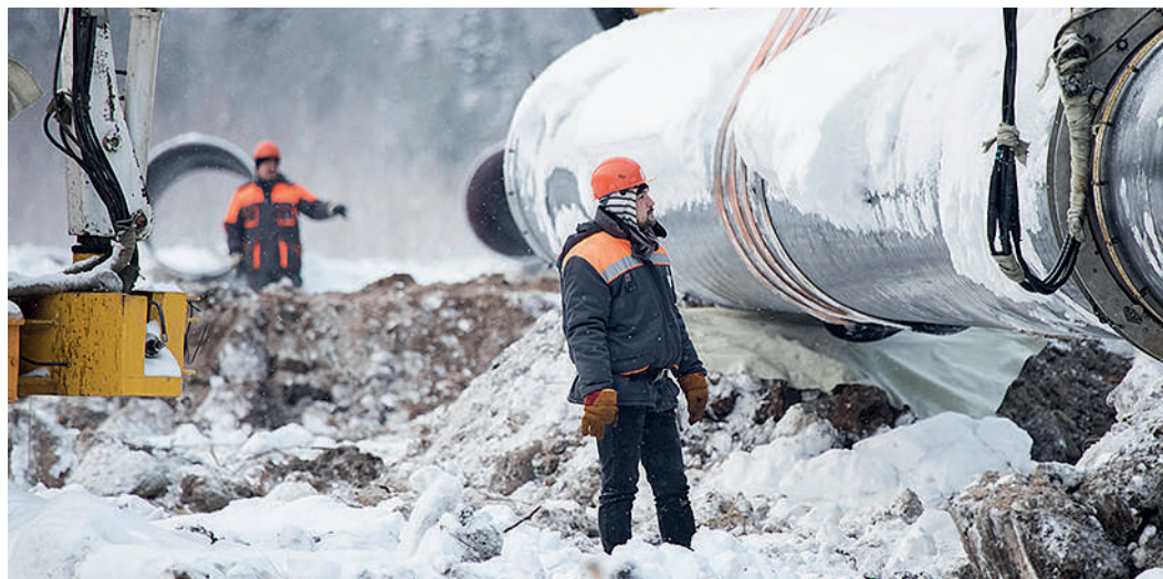
Строительство газопровода «Ухта – Торжок-2» в зоне деятельности Грязовецкого ЛПУМГ
