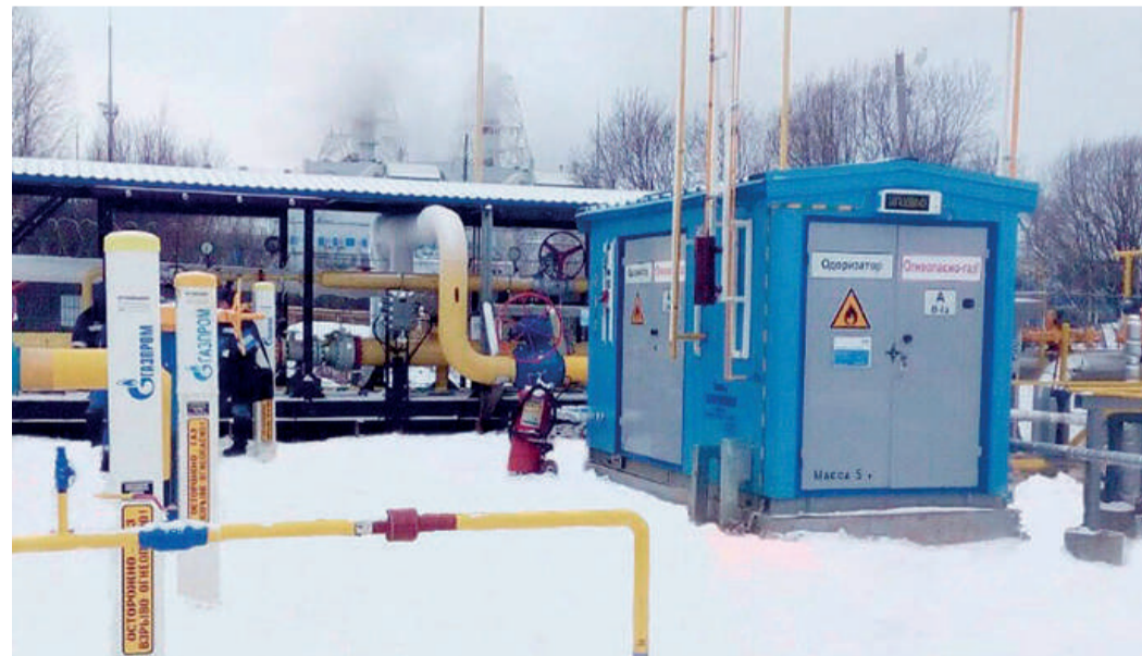
Благодаря вводу ГРС «Тенино» в Ярославской области будет полностью удовлетворена потребность в электроэнергии
