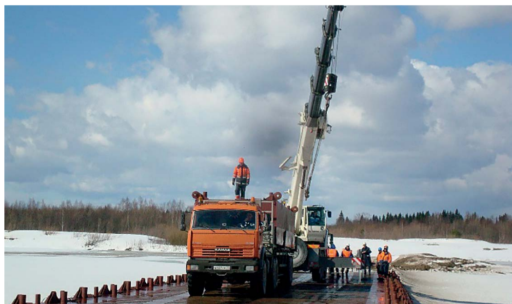
Установка переправы на реке Печоре
