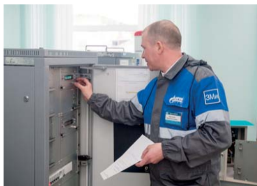
Павел Картошкин, Урдомское ЛПУМГ. Задание по техническому обслуживанию станции катодной защиты
