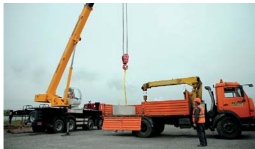
Закладка первого блока фундамента физкультурно-оздоровительного комплекса, Шексна
