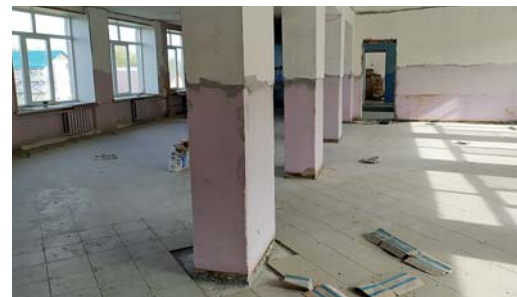
Ход работ по капитальному ремонту школы № 2, Грязовец
