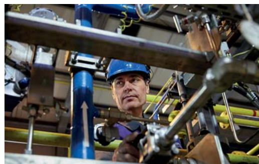
Осмотр манометров, кранов и трубопроводов
