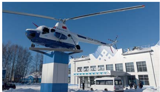
Отремонтированный аэропорт, Ухта
