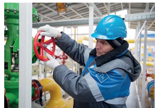
Оператор ГРС 5 разряда Владимир Голованов выполняет расхаживание с контролем плавности хода трубопроводной арматуры
