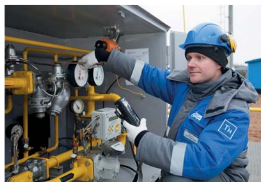
Слесарь по ремонту технологических установок 5 разряда Андрей Куличков выполняет регулировку давления срабатывания предохранительно-запорного клапана
