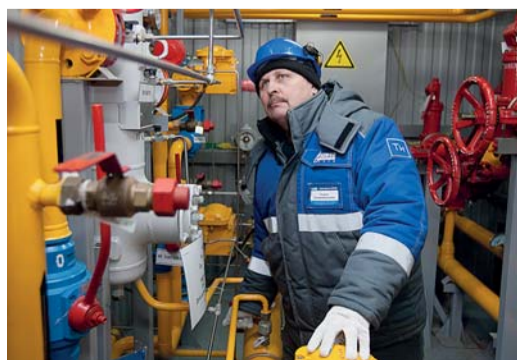
Слесарь по ремонту технологических установок 5 разряда Евгений Ульянов выполняет продувку фильтров-сепараторов узла очистки газа ГРС
