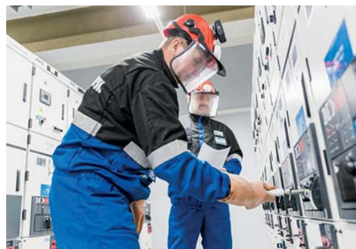
Электромонтёр Сергей Хватов и инженер Александр Перегудов выводят в ремонт ячейки
