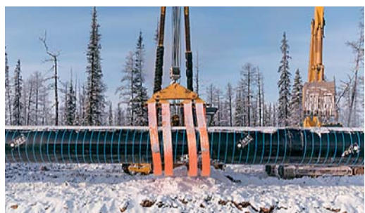
При строительстве газопровода «Сила Сибири» использованы только отечественные трубы
