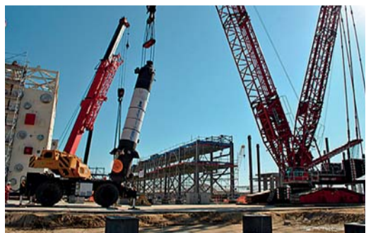
Установка спирального теплообменника на строительной площадке Амурского ГПЗ
