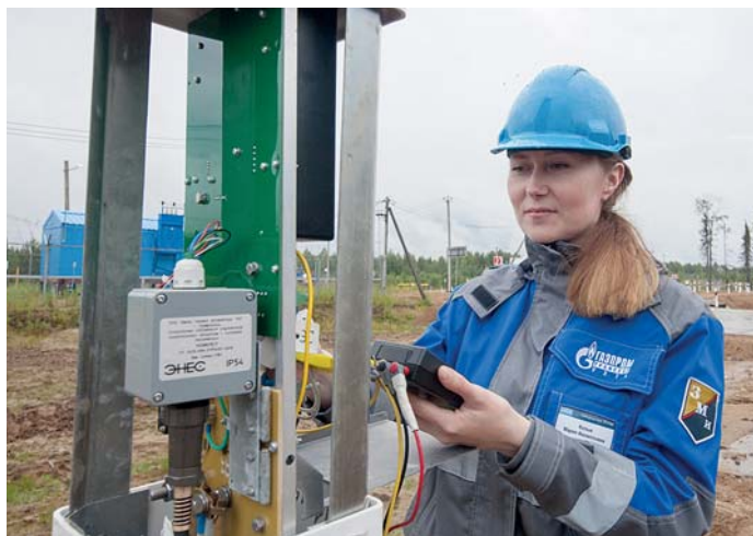
Монтер ЭХЗ Мария Кольм проводит измерение поляризационного потенциала на газопроводе
