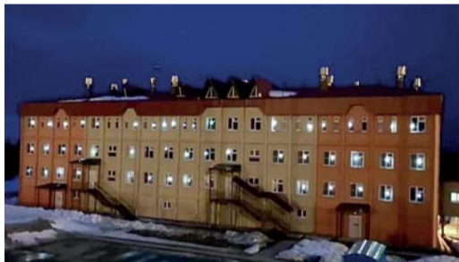
Вахтовый жилой комплекс на КС «Чикшино»
