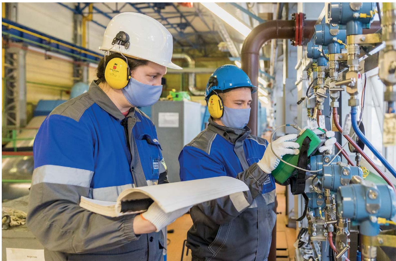
Виталий Мальцев и Сергей Болотовский, инженер и приборист служба автоматизированных систем управления, автоматики и телемеханики, выполняют проверку каналов измерения на ремонтном газоперекачивающем агрегате
