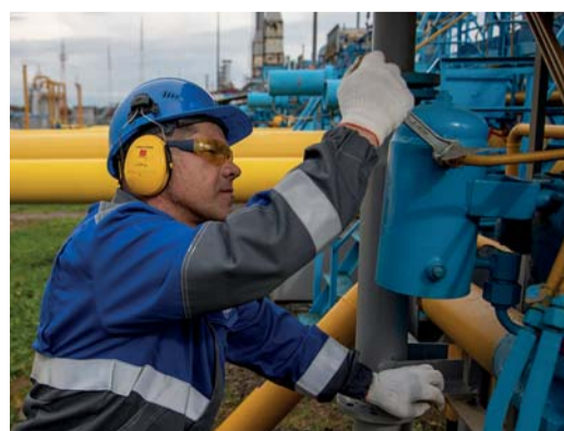
Подключение обвязки запорной арматуры
