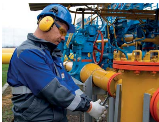
Ревизия фланцевого соединения
