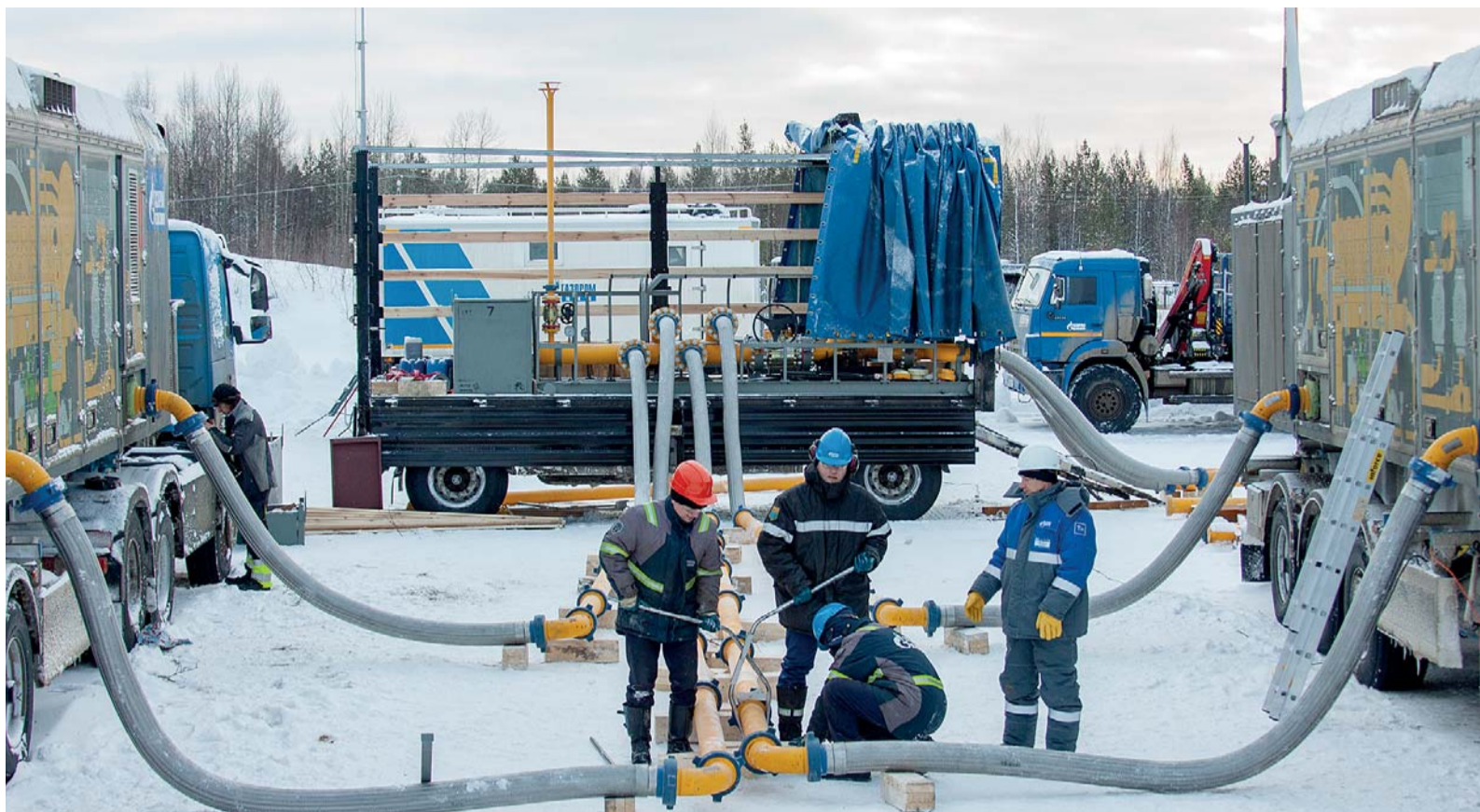
Процесс выполнения монтажа и подключения шлейфов к мобильному компрессорному устройству специалистами ООО «Газпром МКС»
