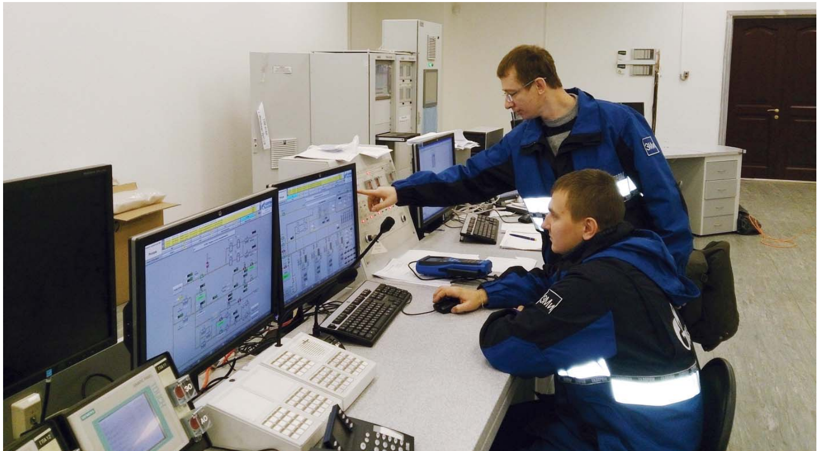
Контроль хода выполнения ПНР системы АСУТП на КС «Чикшинская» Печорского ЛПУМГ выполняют инженеры Ю. А. Шалимов и А.В. Водянов
