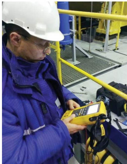
Контрольный замер показаний с датчиков выполняет инженер КС «Сосногорская» М.А. Дмитриев
