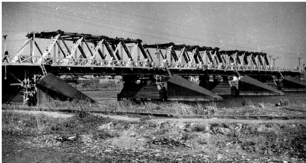
Старый мост через р. Ухта
