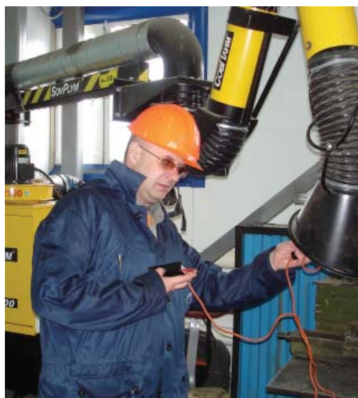
Испытание систем вентиляции
