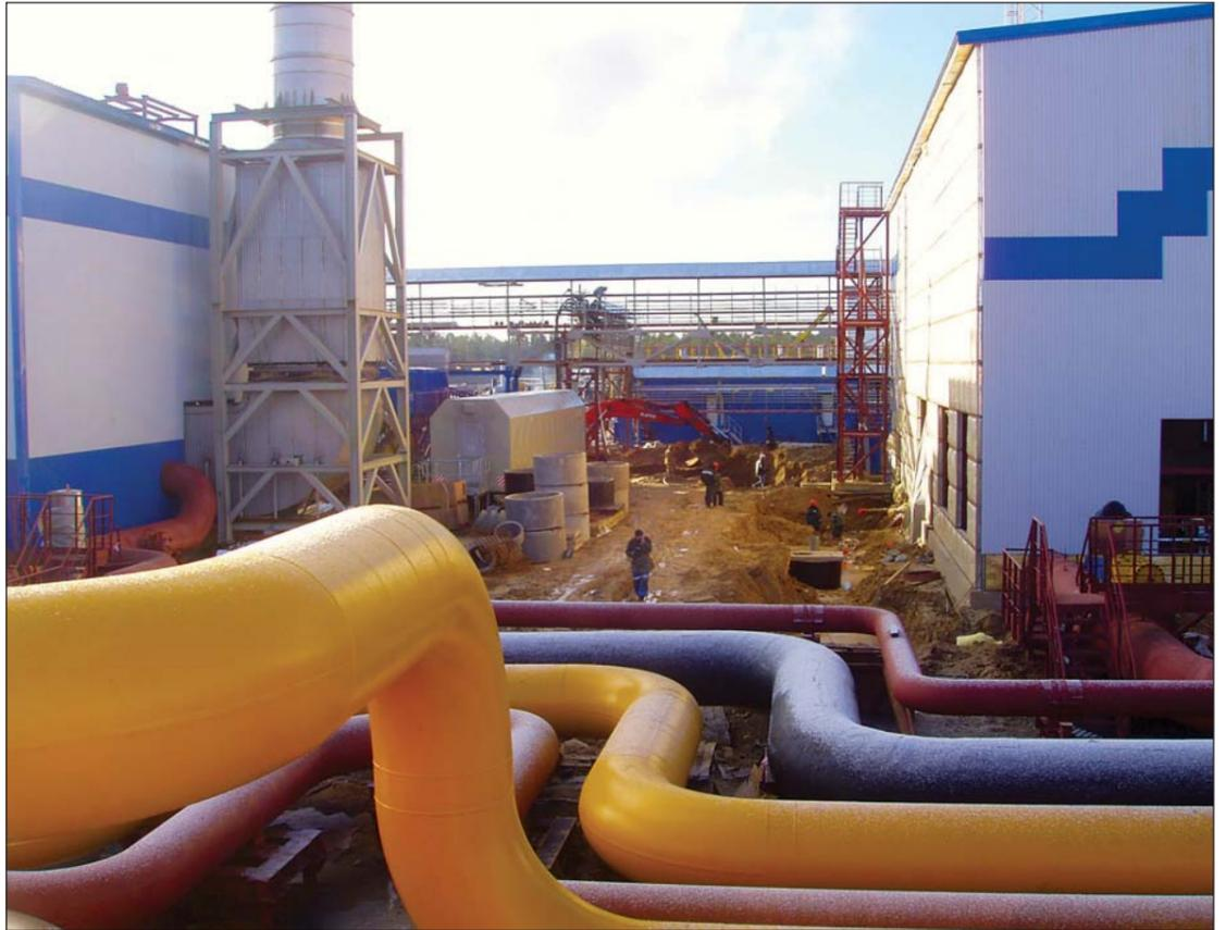
11 октября 2006 года на КС «Вуктыльская» при строительстве компрессорного цеха №5 газопровода СРГО-Торжок впервые в «Севергазпроме» был применен метод осушки трубопроводов межцеховых технологических коммуникаций - вакуумирование.
