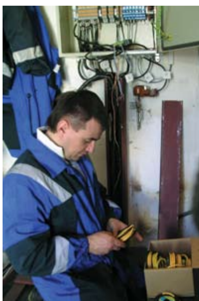
Монтаж САУ ГРС МП на ГРС «Боровская»
