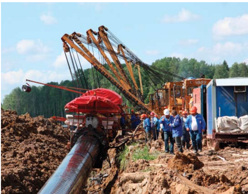
Работы по переизоляции на участке Мышкинского ЛПУМГ
