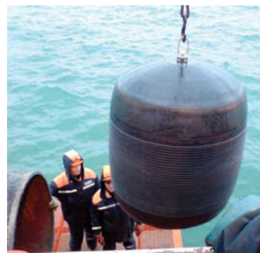
Установка герметизирующего устройства
