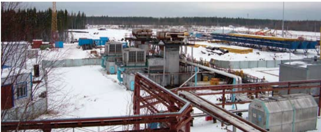
Общий вид площадки реконструкции цеха №3-бис
