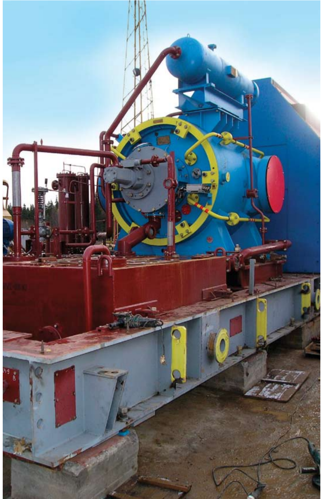
Установка ГПА 12-06 «Урал» на фундамент
