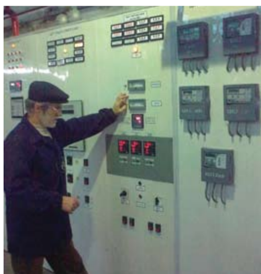
В.В. Лаврентьев (инженер участка АСУ и ТМ ИТЦ). Корректировка настроечных параметров модернизированного щита автоматики, Приводинское ЛПУМГ
