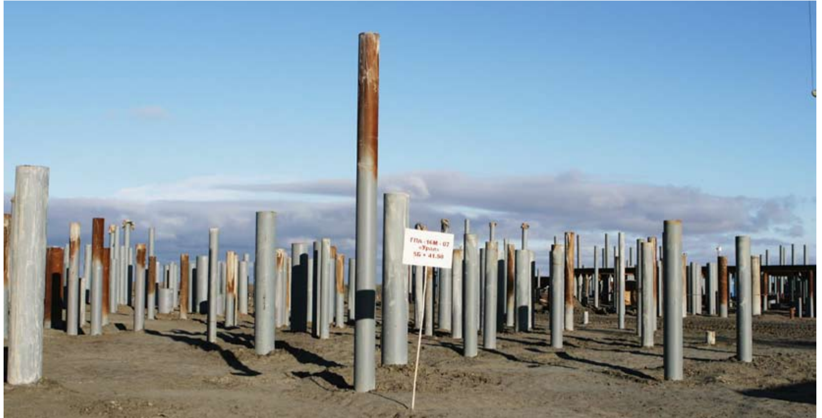
Промплощадка для КС- Байдарацкая
