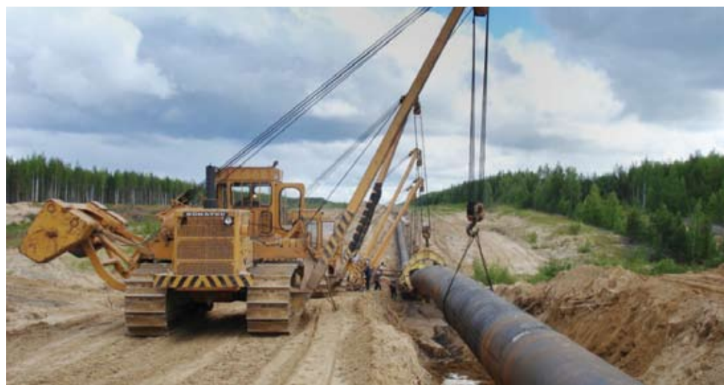
Очистка трубы при переизоляции спр 2 нитка
