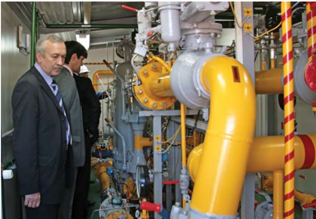
Осмотр газораспределительной станции.
