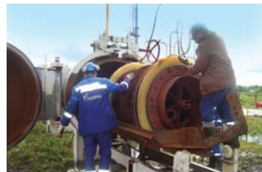
Загрузка скребка в камеру запуска
