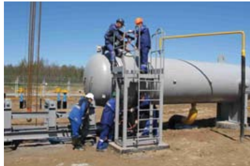
Завершаются ПНР на камере приема поршиней.
