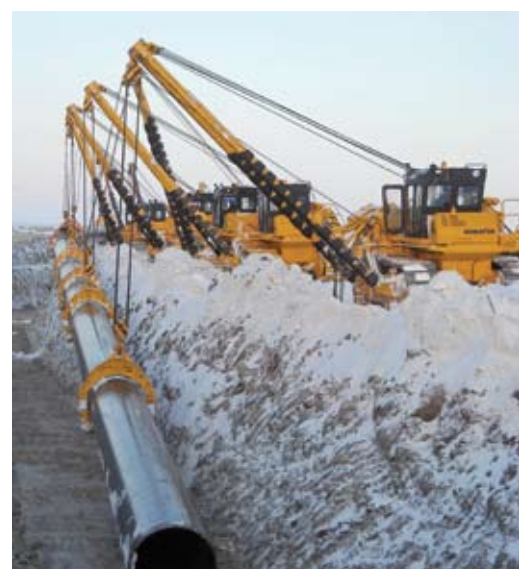
Укладка первой плиты на Ямале.
