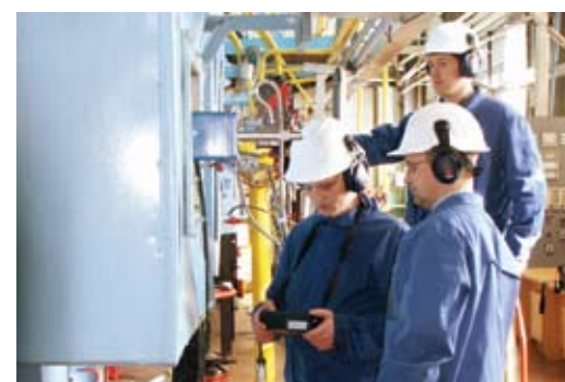
Замер температуры и состава уходящих дымовых газов
