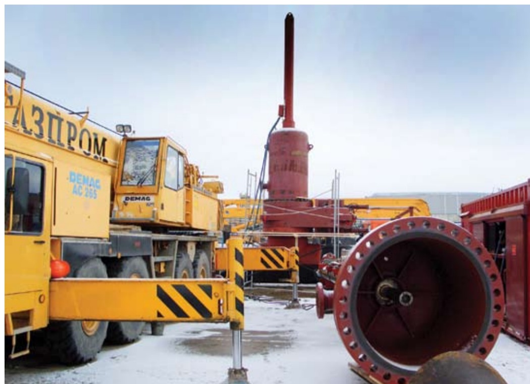
«Стопл» в установленном виде. На переднем плане - привод фрезы диам.1400 мм
