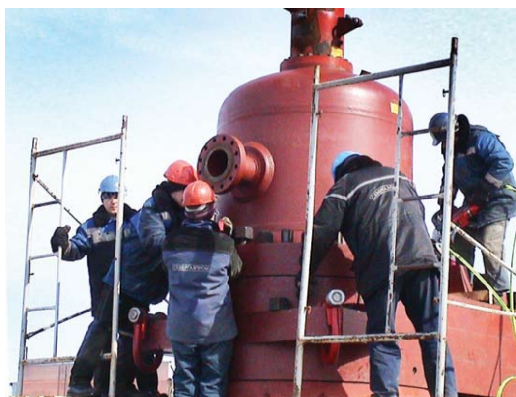
Монтаж фитинга «Стопл»
