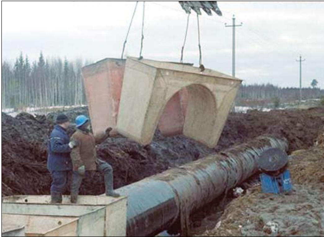
Применение ПКУ при балластировке газопровода
