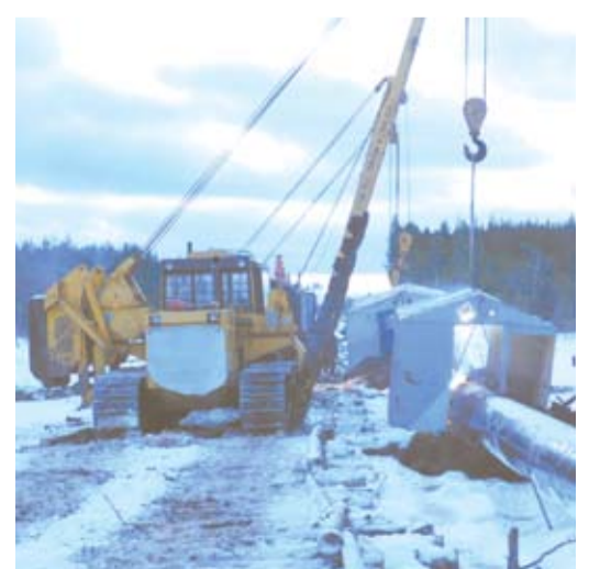
Сварочные работы на трассе
