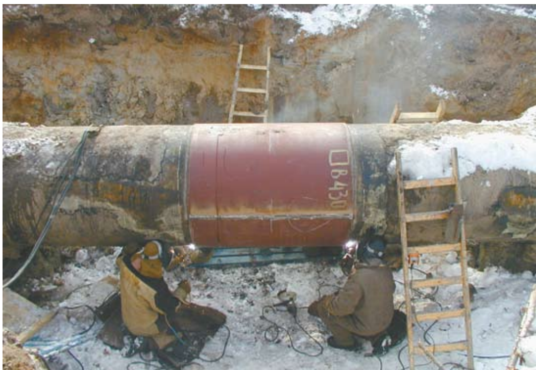
Сварка угловых кольцевых швов
