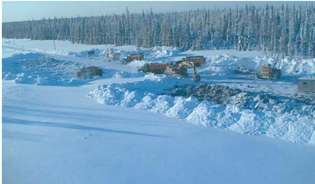
Работа на газопроводе Западный Соплеск
